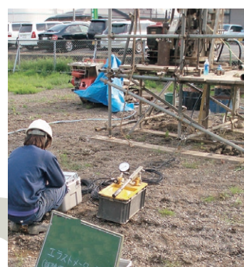
孔内水平載荷試験状況
