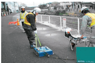
レーダー探査状況
