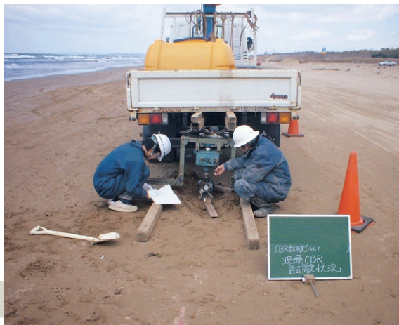
現場CBR試験の状況
