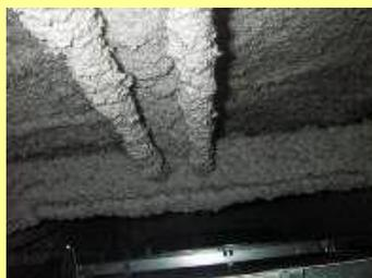
→天井に吹付けられた吹付材。劣化が進んだときに石綿が飛散する可能性があります。
