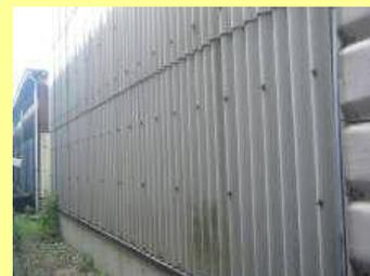
→壁や床などの形成板。飛散する可能性は低いが配管と同様、解体、廃棄するには対策が必要になります。
