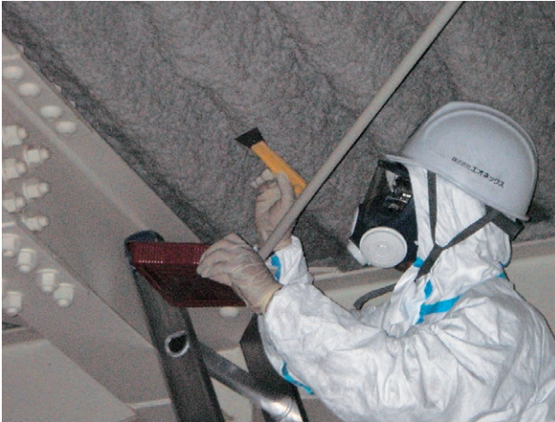
アスベスト含有率測定・試料採取
