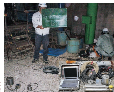
常時微動測定 状況
