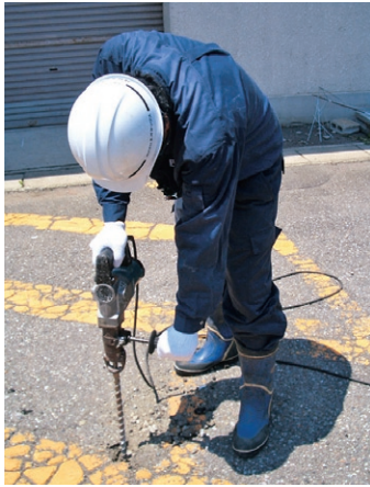
土壤ガス採取孔設置
