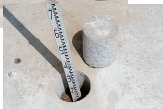
コンクリート削孔後
