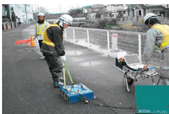
レーダー探査状況
