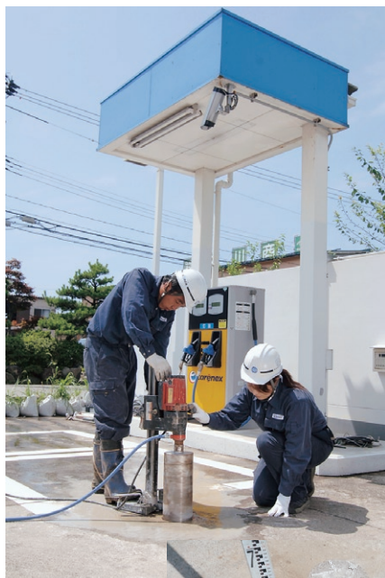
コンクリート削孔中
