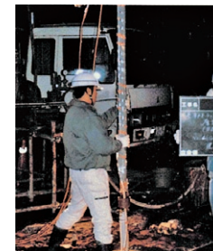
層別沈下計設置例
