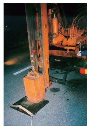
弾性波探査 (起震機の状態)
