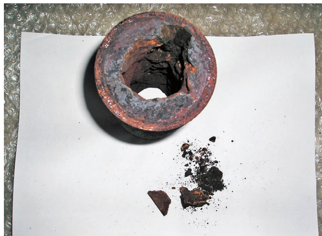
鉄による配管スケール障害
