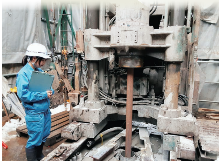
温泉掘削の現場に立つ女性社員
